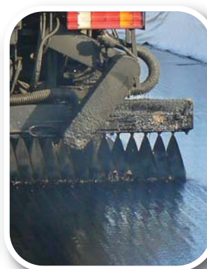
Postřiky, penetrace, nátěry
