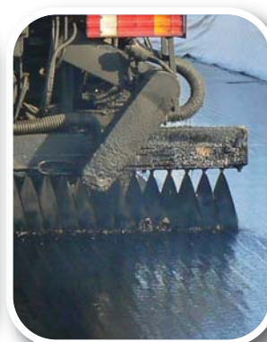
Postřiky, penetrace, nátěry
